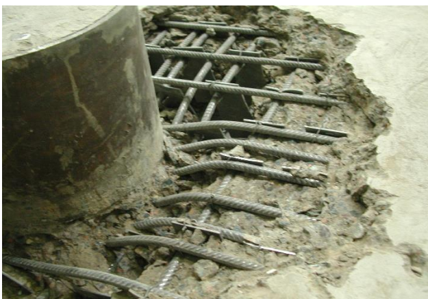
Bild 4.17.2: Verbogene Grundbewehrung
