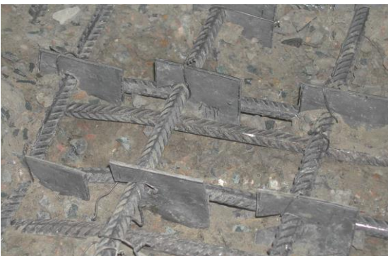
Bild 4.14.2 und 4.14.3: Verformte Einbauteile
