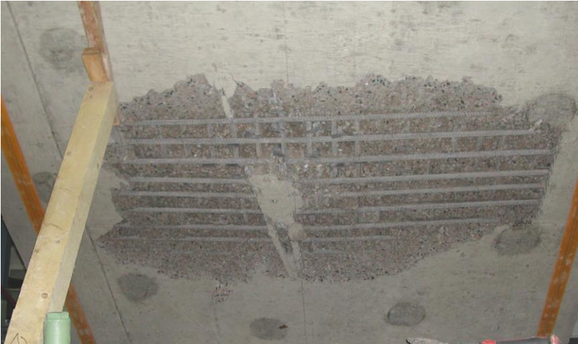
Bild 4.14.1: Bruchbild nach dem Freistimmen
