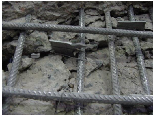
Bild 4.19.2: Verformtes Einbauteil
