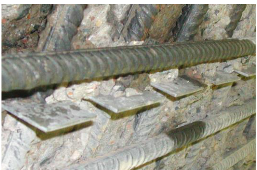
Bild 4.18.3: Unverformtes Einbauteil
