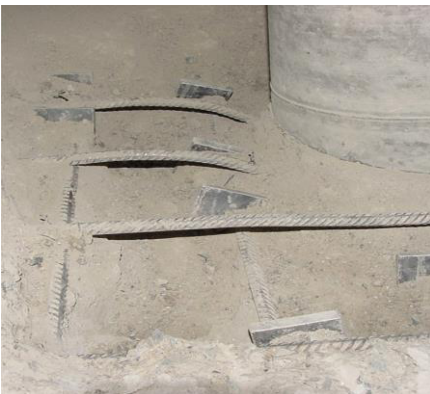
Bild 4.11.2: Aufbiegung der Einbauteile
