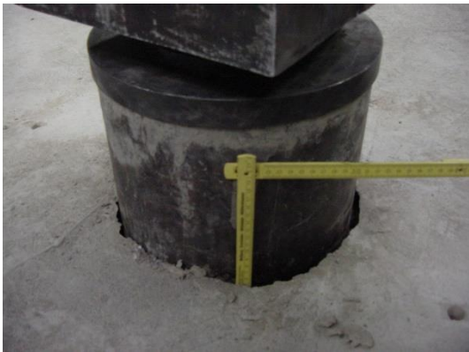
Bild 4.19.1: Stützensenkung
