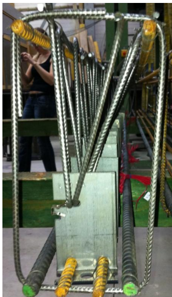
Abb.3: L-Blech im Einbauzustand-Rechteckquerschnitt
