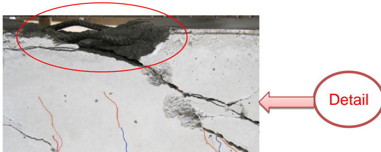
Abb.22: zerstörte Betondruckzone (Körper AA1)
