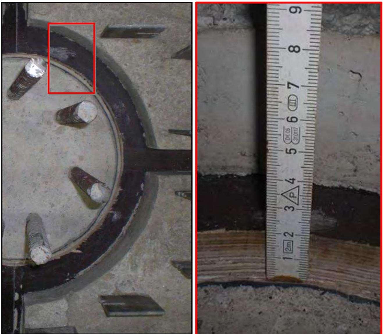
Planmäßige Fehllage – Stütze ist 20 [mm] unterhalb der Plattenunterkante betoniert
