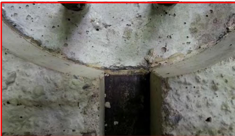
Keine Fuge zwischen Halbfertigteil und Stütze
