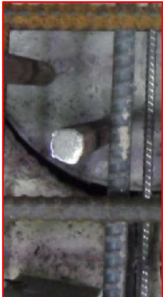
Planmäßige Fehllage – Stütze ist 10 [mm] in die Platte betoniert
