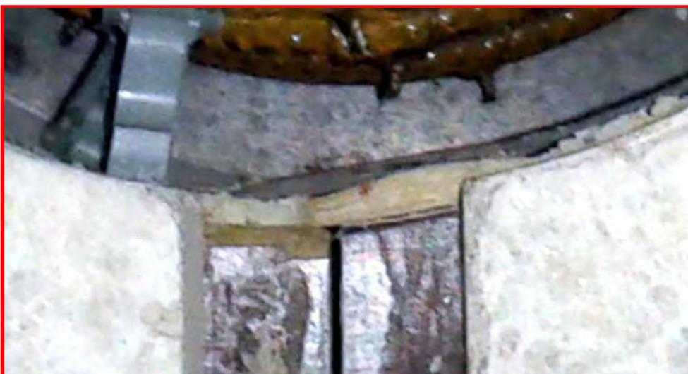
Keine Fuge zwischen Halbfertigteil und Stütze
