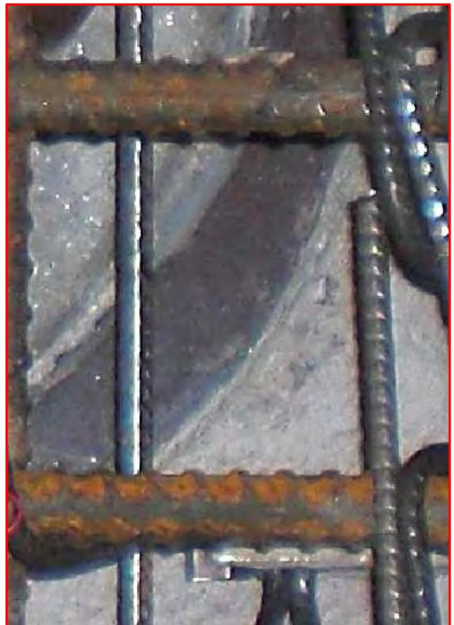
Planmäßige Fehllage – Stütze ist 5 [mm] in die Platte betoniert
