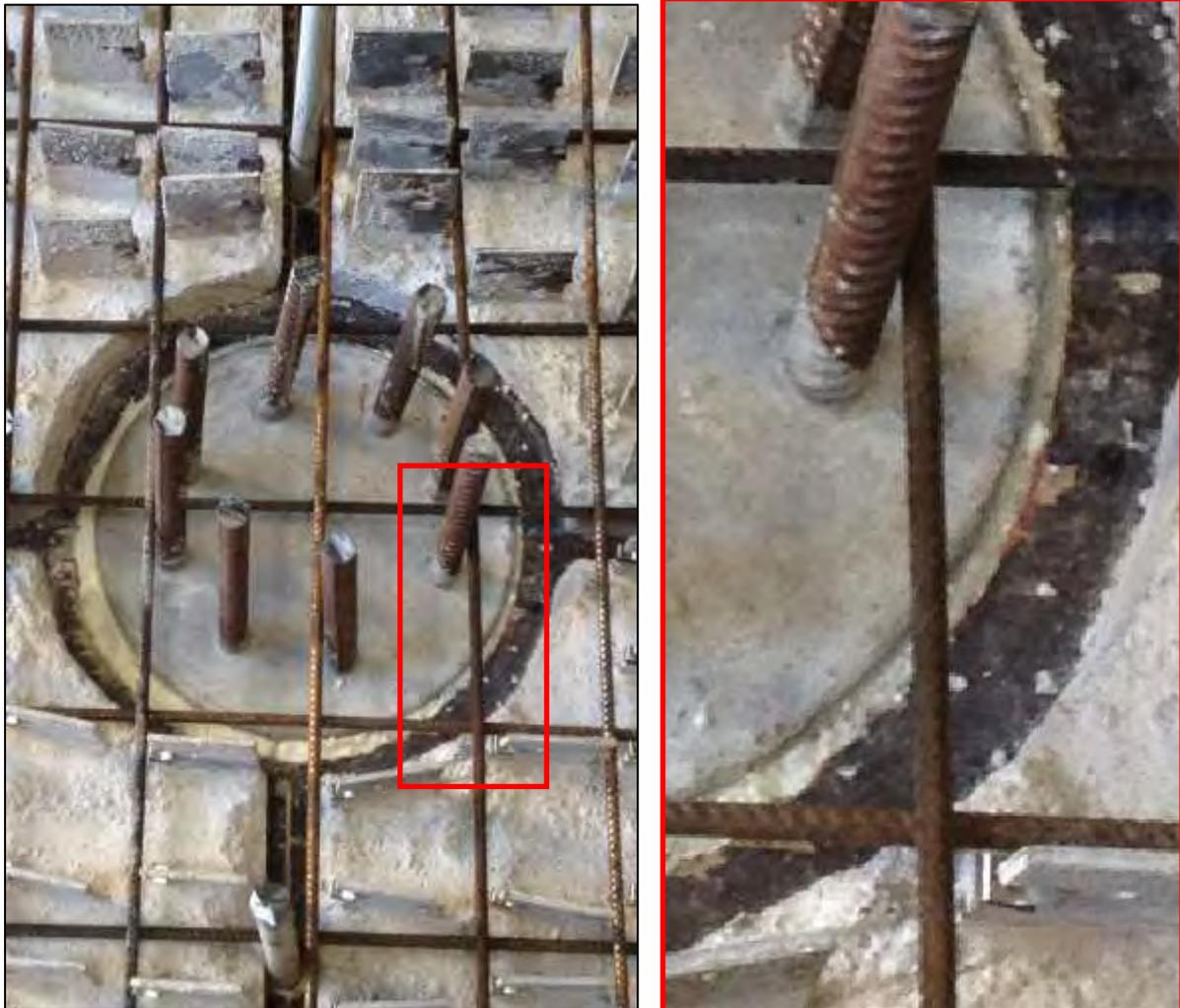
Planmäßige Fehllage – Stütze ist 5 [mm] in die Platte betoniert
