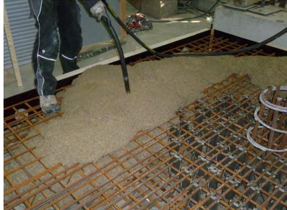
Abbildung A9: Verdichtung des Betons
