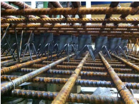
Abbildung A6: CLIXS-Durchstanzbewehrung mit eingehängten Bügeln
