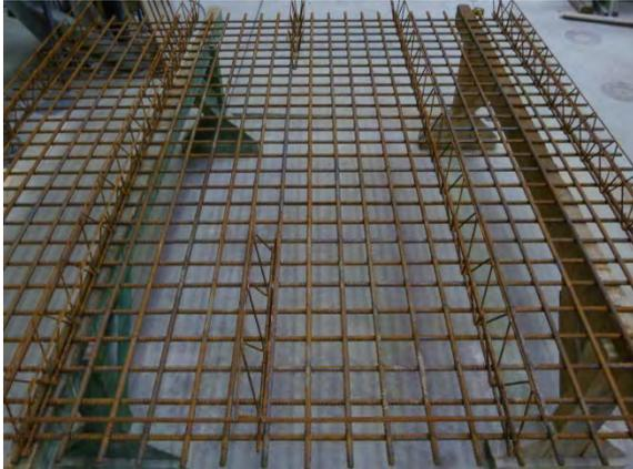
Abbildung A2: Bewehrung aus Spannstahl mit Gitterträgern als Abstandshalter
