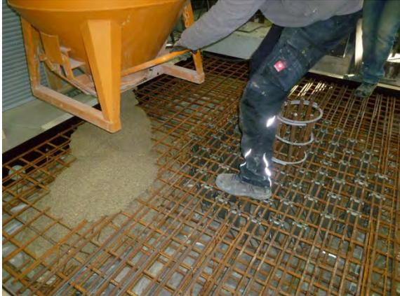
Abbildung A8: Einbringen des Frischbetons
