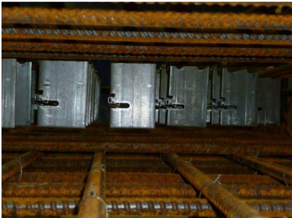
Abbildung A4: Eingebaute CLIXS-Durchstanzbewehrung: Seitenansicht
