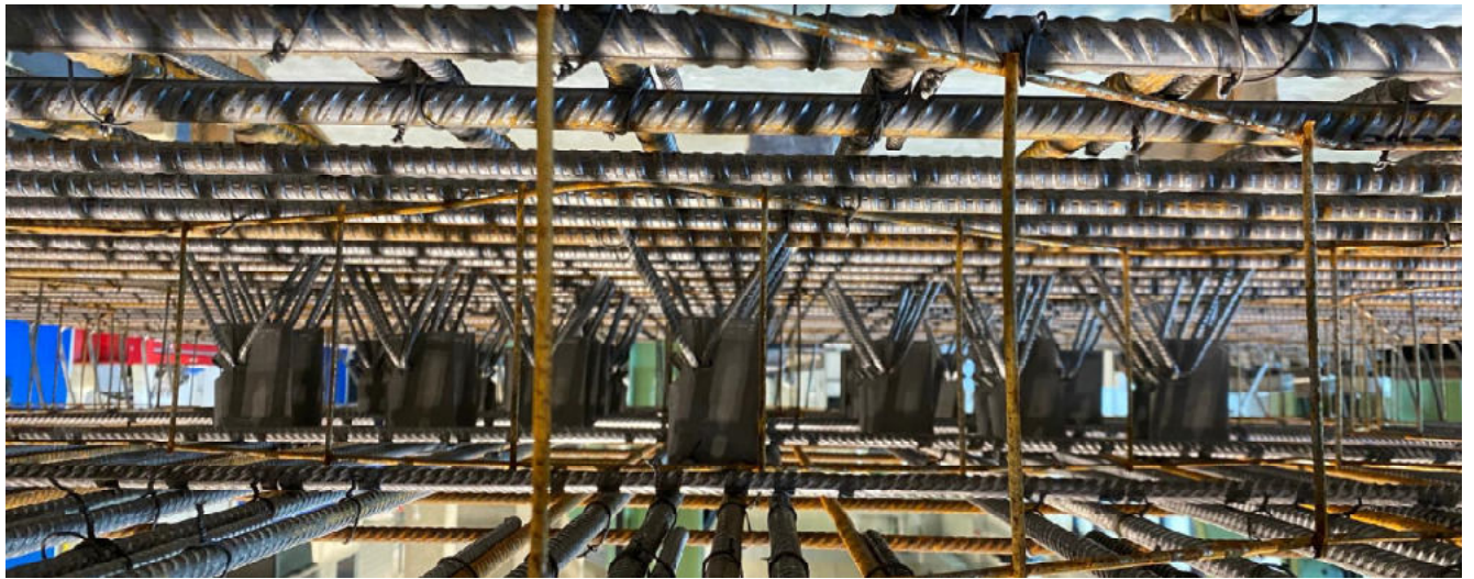
Abbildung 3: Einbau der Bügel und Bleche
