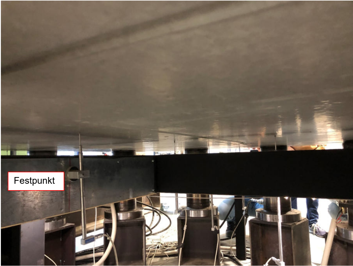
Wegaufnehmer im eingebauten Zustand
