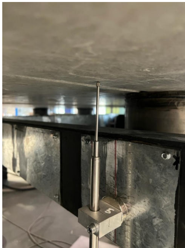
Wegaufnehmer im eingebauten Zustand
