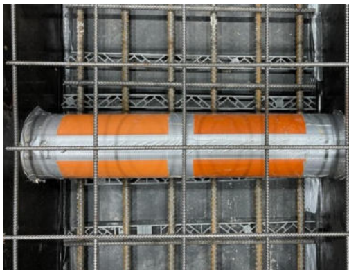
Fixierung der oberen Bewehrung mit \text{Ø}12 auf der Schalung. Entfernung nach dem Betonieren.
