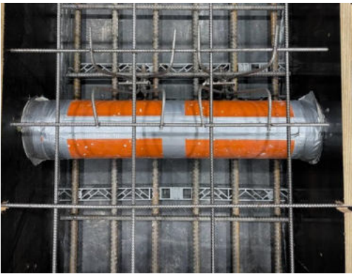
Die obere Bewehrung wurde in 2cm tiefe Schlitz in der Schalung eingelegt.
