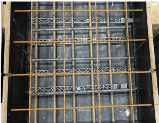
Die Øbere Bewehrung wurde in 2cm tiefe Schlitze in der Schalung eingelegt.
