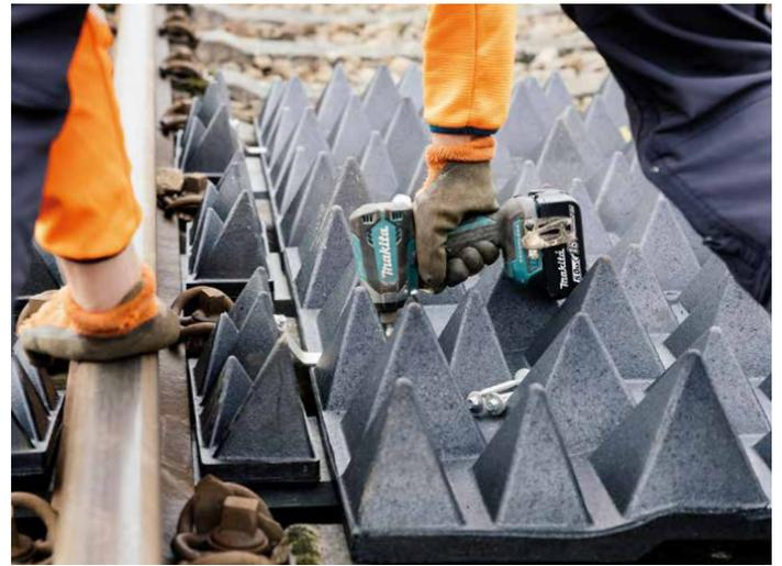
Links: Auf Korsika verhindert STRAILgrid, dass Wild- und Weidetiere in die Eisenbahntunnel eindringen. Rechts: STRAILgrid lässt sich individuell an die Gegebenheiten vor Ort anpassen – die Universalplatten werden unkompliziert mit Schrauben fixiert.
