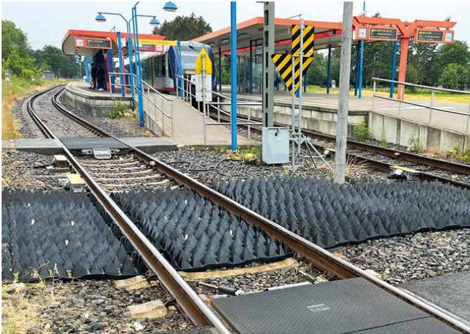
Am stark frequentierten Bahnhof Ulzburg-Süd wurden 30 m<sup>2</sup> STRAILgrid in weniger als vier Stunden eingebaut.
